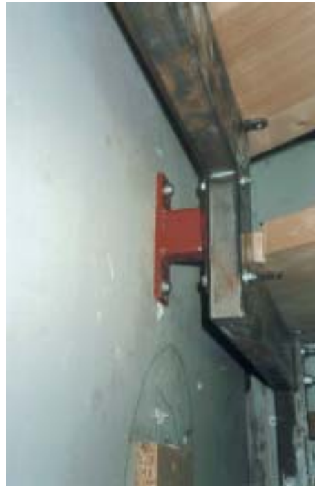
Bild 6: gängiges Auflager zur Lastabtragung bei einer Stahl-Holz-Treppe
